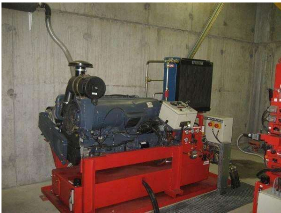
Ejemplos de motor térmico secundario (izquierda) y motor eléctrico principal (derecha) en La Massana, Andorra.
