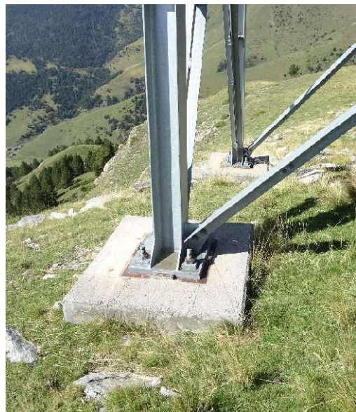
Cimentación de torre
