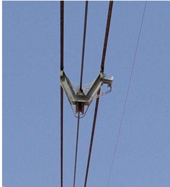
“Caballete” uniendo dos cables portadores (extremos) y un tractor (al centro, encima de una pequeña polea).
