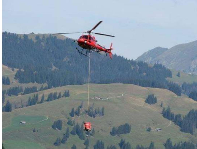
Transporte y vertido de hormigón por helicóptero
