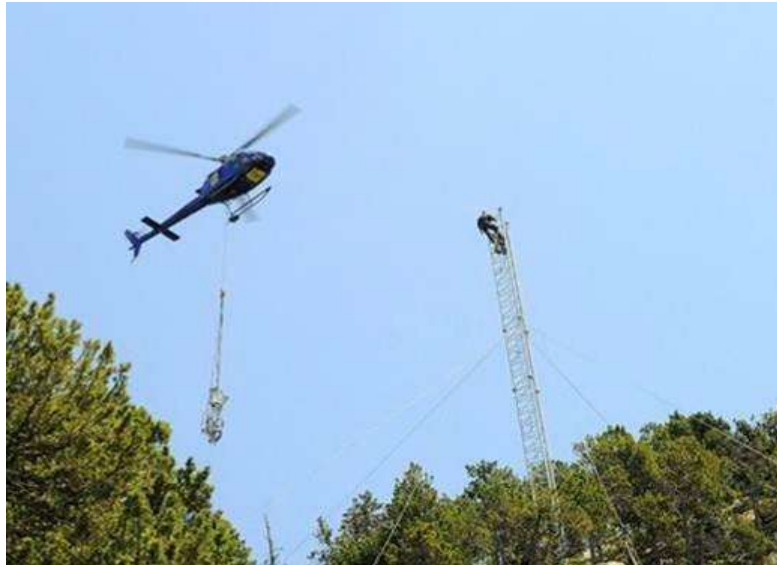
Montaje de un blondín (con la ayuda de un helicóptero), que posteriormente se utilizó para el montaje de la línea de un telesilla.
