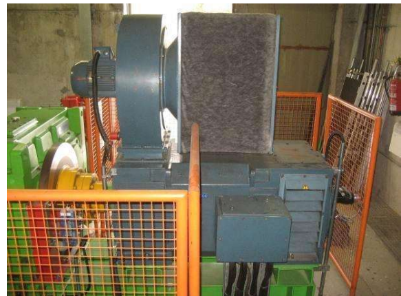
Ejemplos de motor térmico secundario (izquierda) y motor eléctrico principal (derecha) en La Massana, Andorra.
