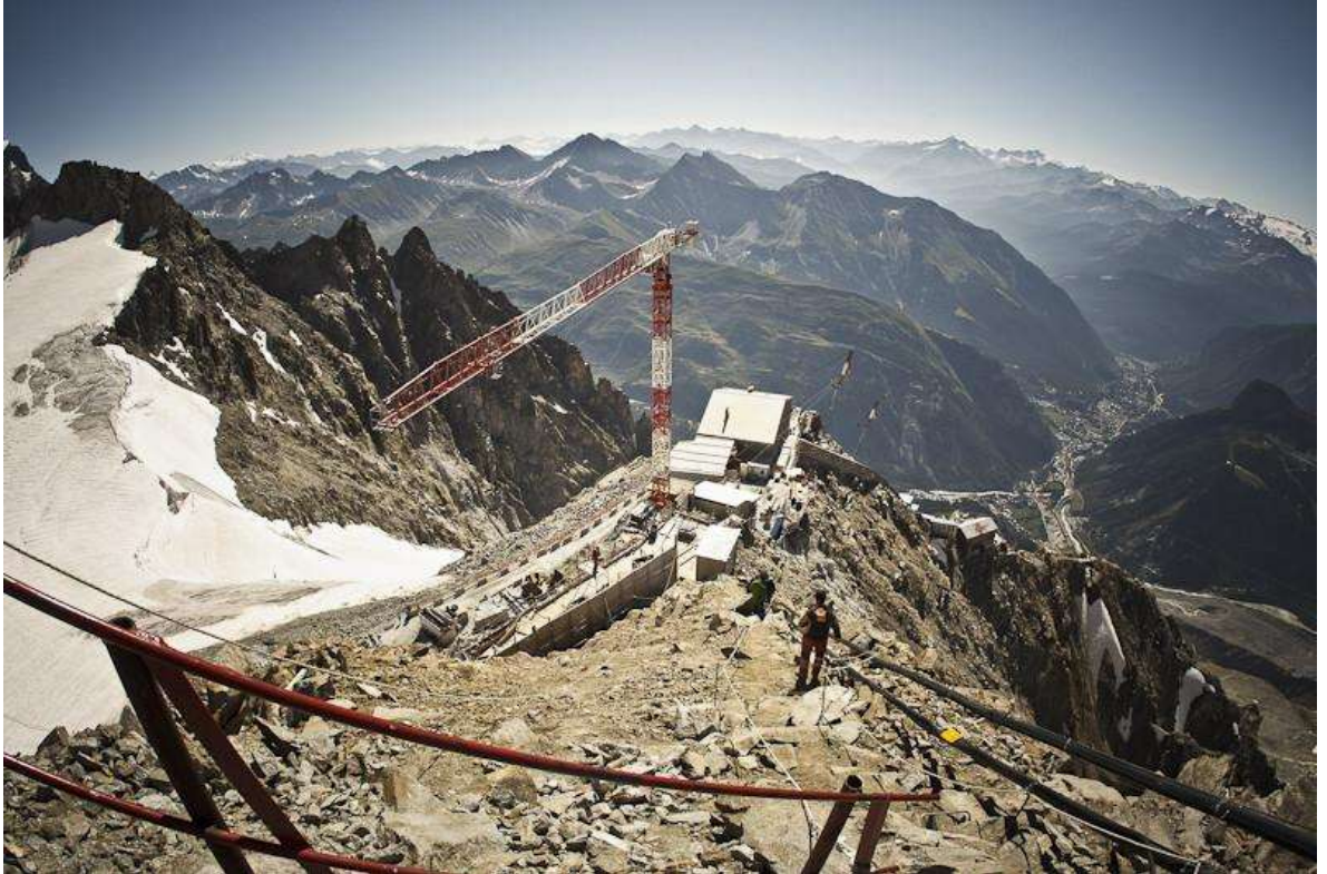
Fotografía de las obras de la estación superior del teleférico del Mont Blanc (Copurmayer a Punta Helbronner). Fuente: www.lovecourmayeur.com
