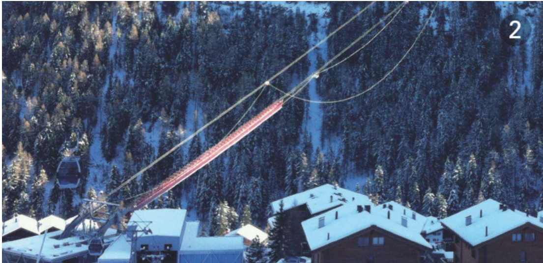
Montaje de “puente” suspendido provisional par a la maniobra de empalme de un cable tractor de teleférico. Fuente: www.fatzer.com
