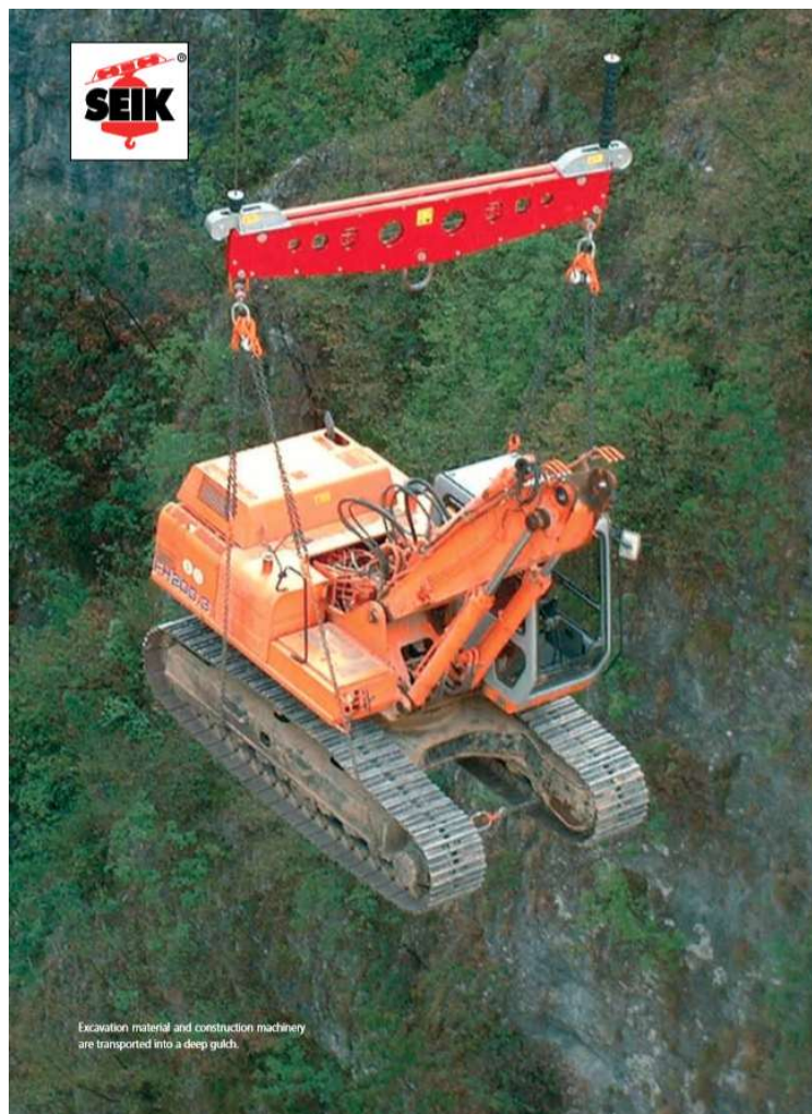
Transporte de máquina excavadora mediante teleférico de materiales. Fuente: www.seik.it .
