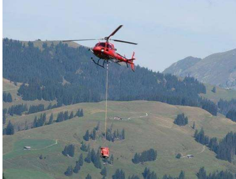
Transporte y vertido de hormigón por helicóptero
