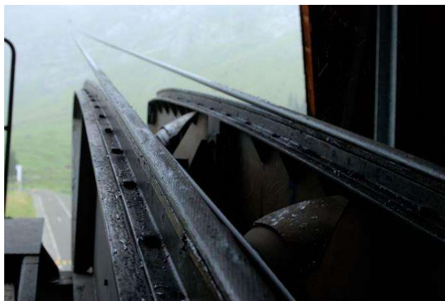
Visión de un par de “zapatras” guiando los 2 cables portadores a la salida de una estación.
