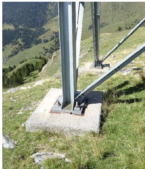
Cimentación de torre
