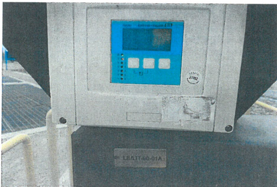
INDICADOR-TRANSMISOR DE NIVEL LIT-90-01 A
