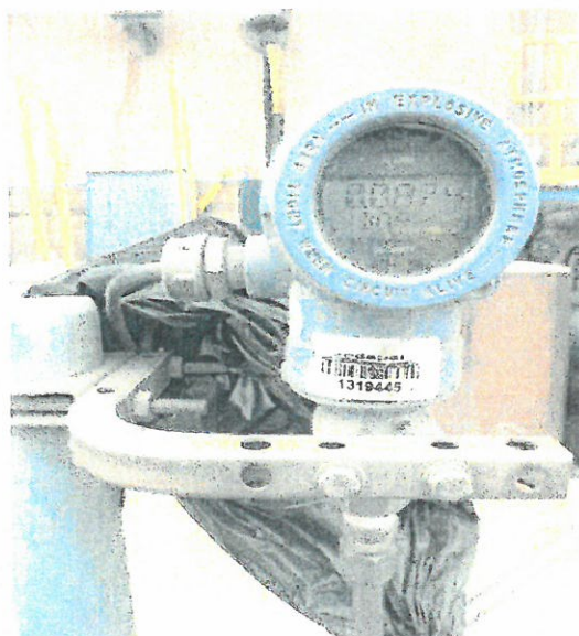
SENSOR E INDICADOR-TRANSMISOR DE PRESION PIT-30-004
