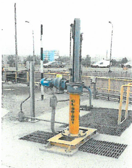
COMPUERTA MOTORIZADA CANAL DE LIMPIA CL-90-01
