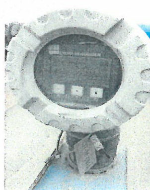
SENSORES TRANSMISORES DE NIVEL LE/LIT-30-013/014/015/016
