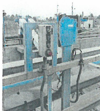
FALTA DEL INDICADOR- TRANSMISOR DE TORQUE WIT- 10-001B
