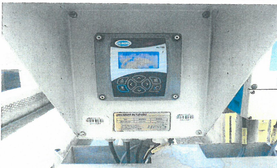
INDICADOR-TRANSMISOR DEL SENSOR DE TURBIEDAD AIT-90-002
