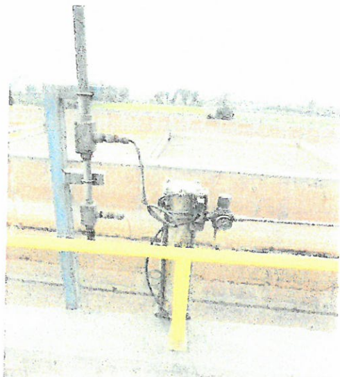
COMPUERTAS NEUMATICAS ENTRADA A FILTROS CN-30-03 A/B
