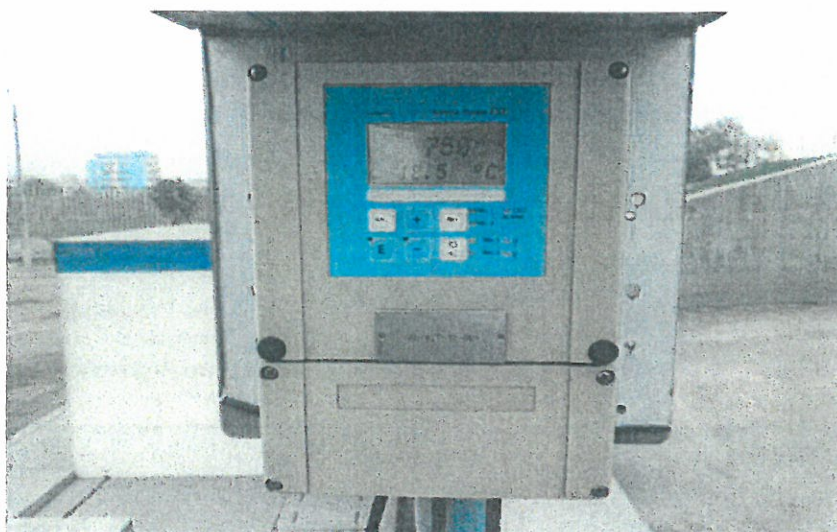
INDICADOR -TRANSMISOR DEL SENSOR DE CONDUCTIVIDAD AIT-10-001
