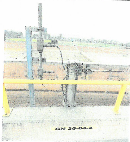
COMPUERTAS NEUMATICAS ENTRADA A FILTROS CN-30-04 A/B
