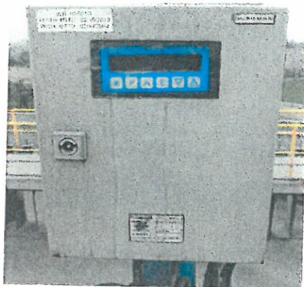
SENSOR E INDICADOR-TRANSMISOR DE TORQUE WE/WIT 10-001G
