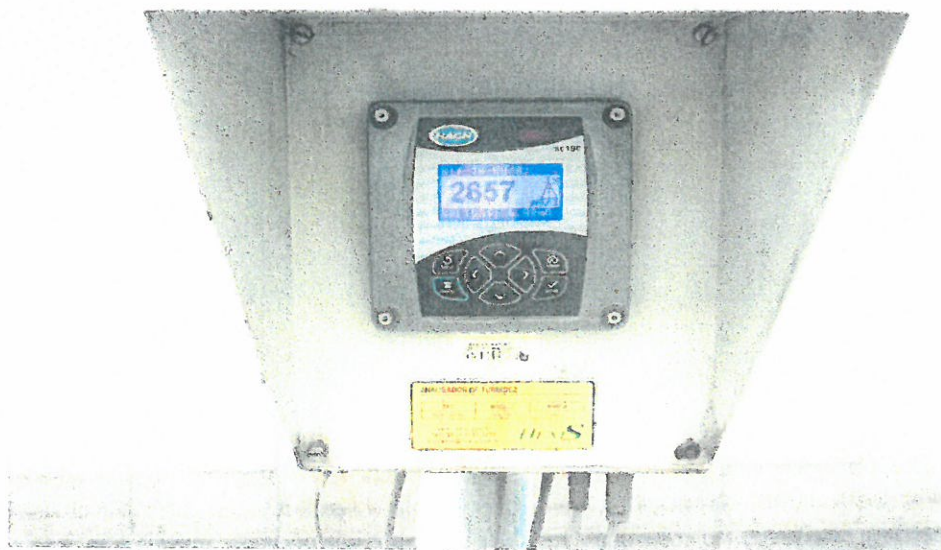
INDICADOR -TRANSMISOR DEL SENSOR DE TURBIDEZ AIT-10-003
