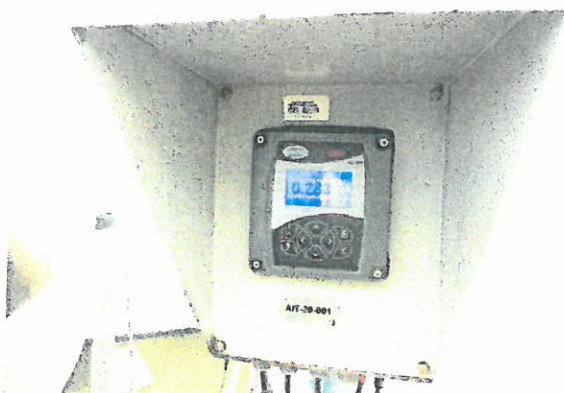
INDICADOR-TRANSMISOR DEL SENSOR TURBIDEZ AIT-20-001 A/B
