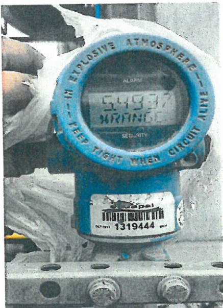
SENSOR E INDICADOR-TRANSMISOR DE PRESION PIT-30-003
