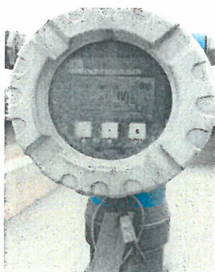
SENSORES TRANSMISORES DE NIVEL LE/LIT-30-013/014/015/016
