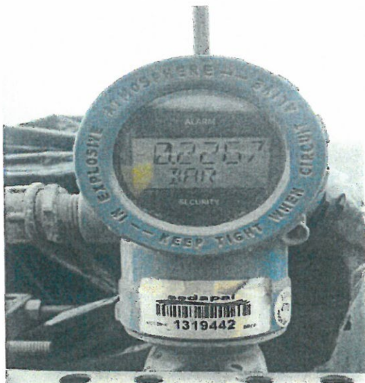
SENSOR E INDICADOR-TRANSMISOR DE PRESION PIT-30-001
