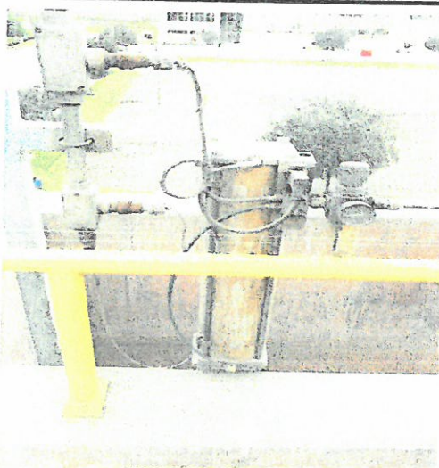
COMPUERTAS NEUMATICAS ENTRADA A FILTROS CN-30-16 A/B
