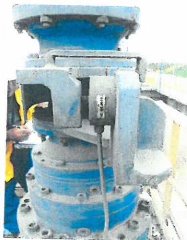
SENSOR E INDICADOR-TRANSMISOR DE TORQUE WE/WIT 10-001G
