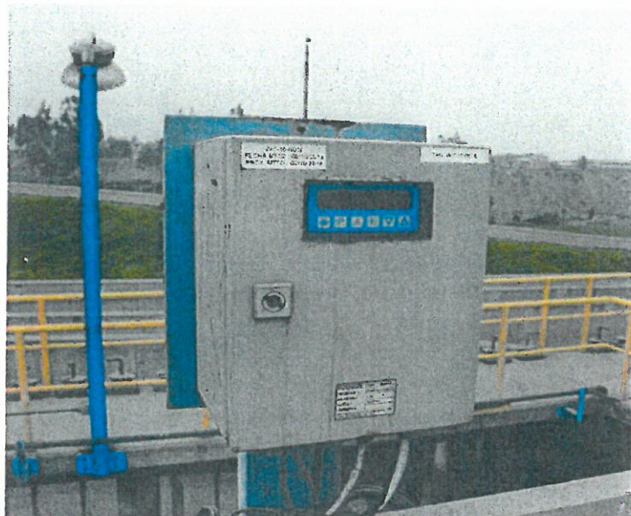
SENSOR E INDICADOR-TRANSMISOR DE TORQUE WE/WIT-10-001E
