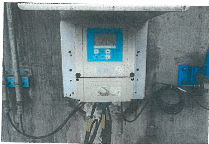
INDICADOR-TRANSMISOR DE ANALIZADOR DE PH AE-20-005
