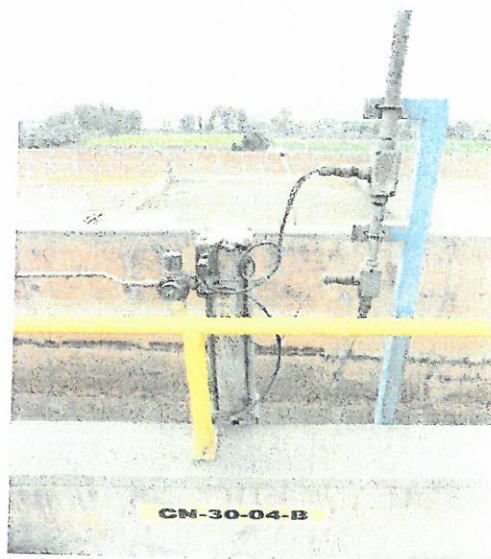
COMPUERTAS NEUMATICAS ENTRADA A FILTROS CN-30-04 A/B
