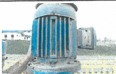
PINTURA EN MAL ESTADO, PRESENCIA DE OXIDO
