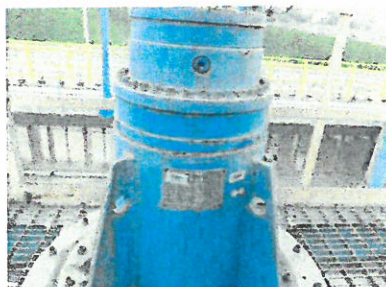
PINTURA EN MAL ESTADO, PRESENCIA DE OXIDO
